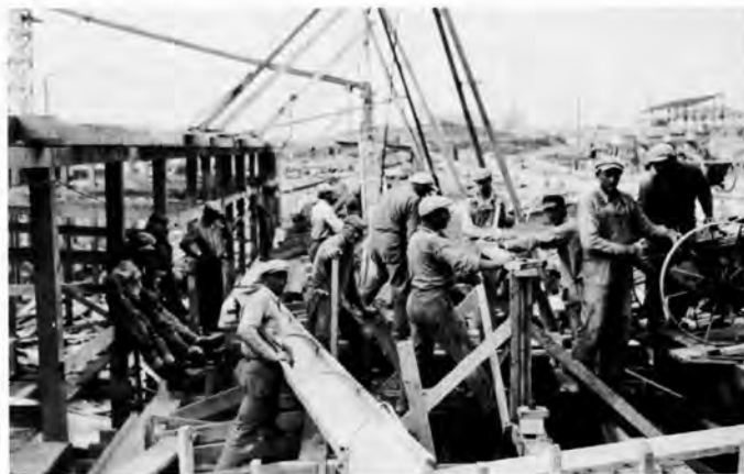
Workers pouring cement. (H. Ennis 1929)
